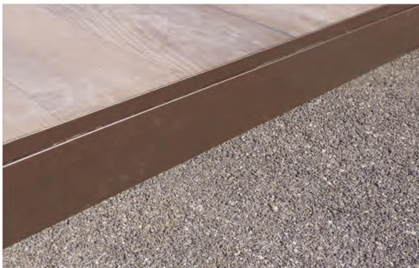
Il profilo del perimetro in lamiera viene abbinato ad un ulteriore lamiera a "L" che funge da chiusura (battiscopa) tra il profilo perimetrale e il sottofondo su cui appoggia il pavimento, compensando e chiudendo il lato (si evita che sporco e foglie vadano sotto il deck).
