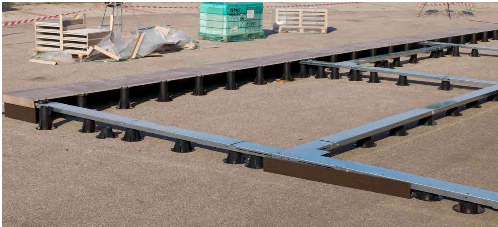
LA STRUTTURA PERIMETRALE HA LA FUNZIONE DI CONTENERE LE LASTRE IN GRES E FISSARE LA CHIUSURA LATERALE COMPENSANDO I DISLIVELLI TRA SOTTOFONDO E PAVIMENTO IN GRES.
